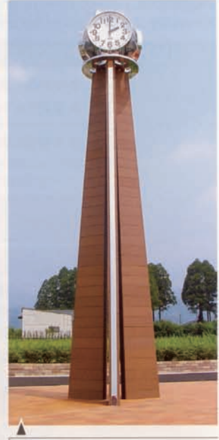
■ 物件：公園 ■ 場所：宮崎県都市 ■ 完成：2007年3月 ■ 使用部材：30×145 無垢片面リブ E08
