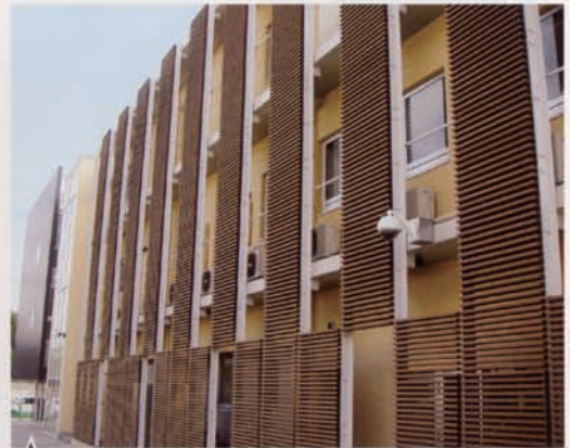
■ 物件：戸畑消防署 ■ 使用部材：30×145 中空両面フラット ■ 場所：福岡県北九州市 ■ 完成：2007年12月
